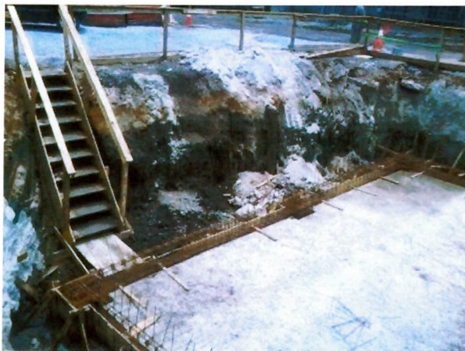
Acesso à construção da Caixa Separadora de Água e Óleo
