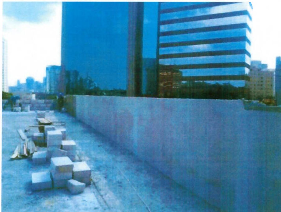
Platibanda – elemento civil onde serão instalados rufos e calhas
