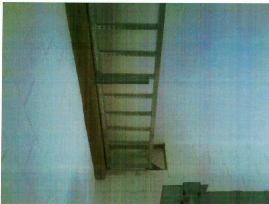
Nichos em laje para subidas dos bandejamentos
