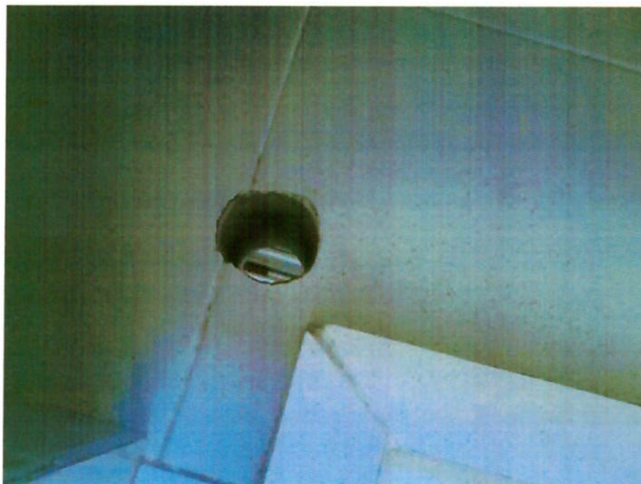
Nicho deixado em laje de concreto
