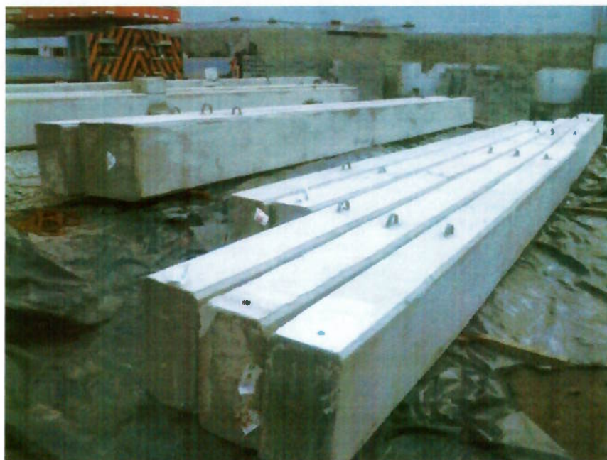
Estoque adequado das peças pré-moldadas
