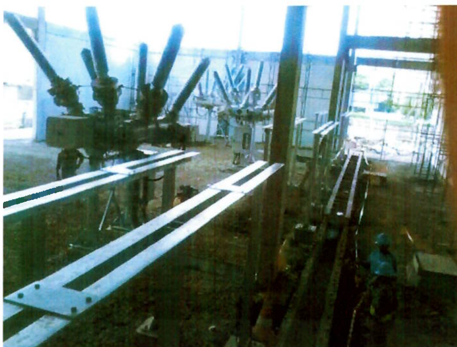
Montagem da estrutura galvanizada das seccionadoras
