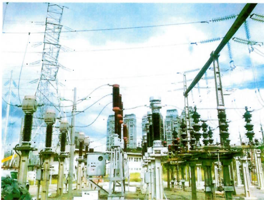
Figura 10 – ETD Monções, em São Paulo-SP. Ampliação de estrutura existente para alimentação de subestação nova.
