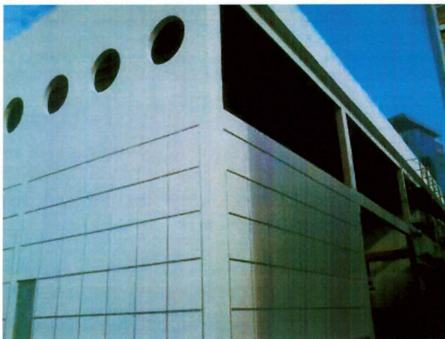
Textura acrílica sobre massa única
