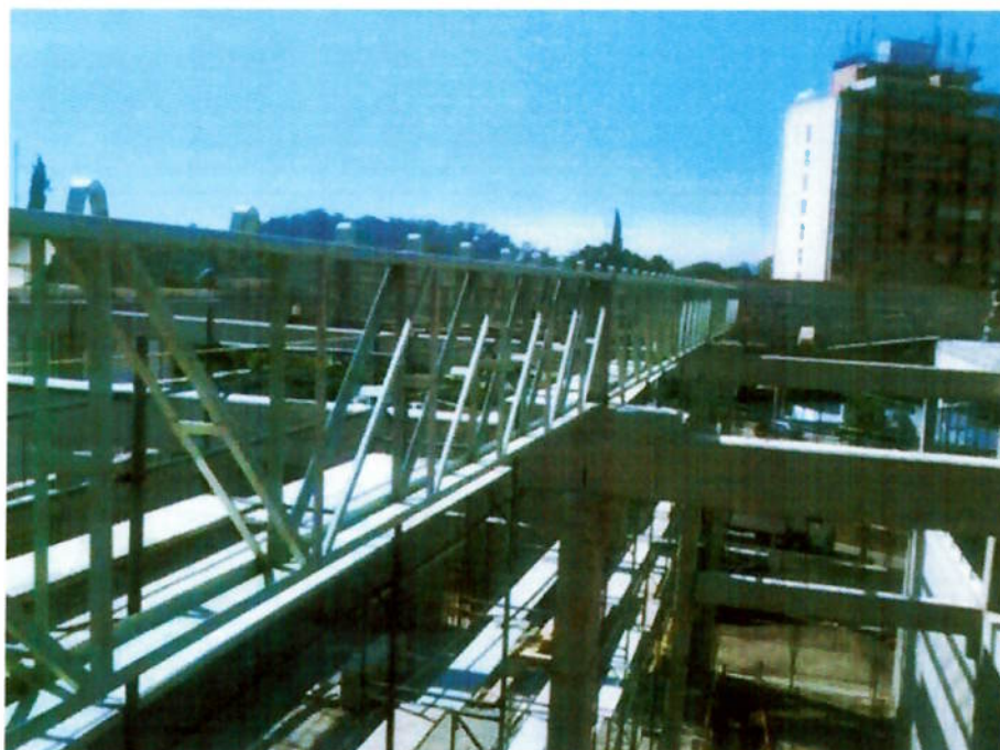
Instalação da treliça de apoio central
