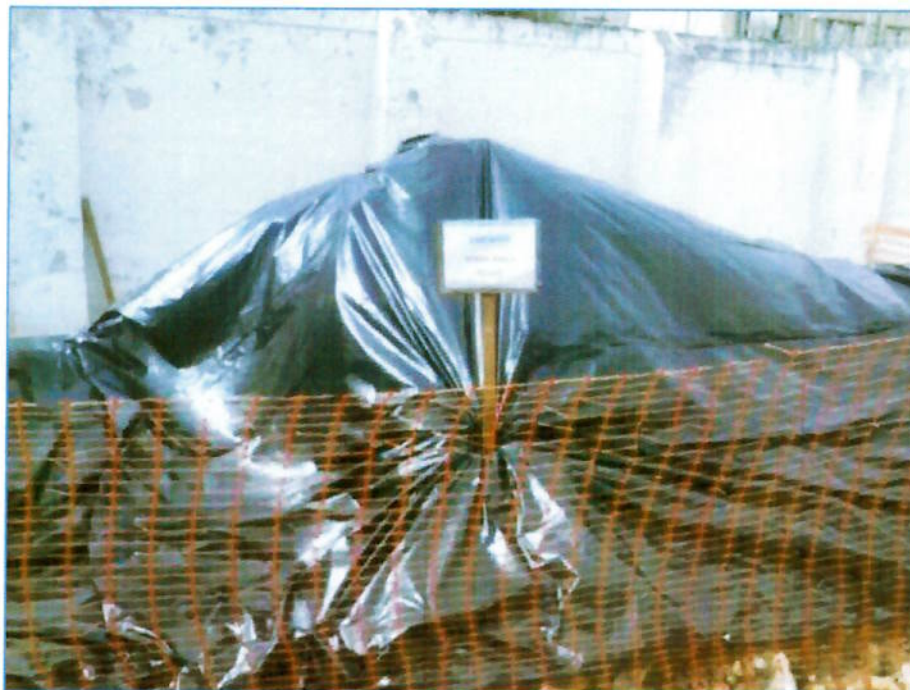
Solo escavado aguardando reaproveitamento
