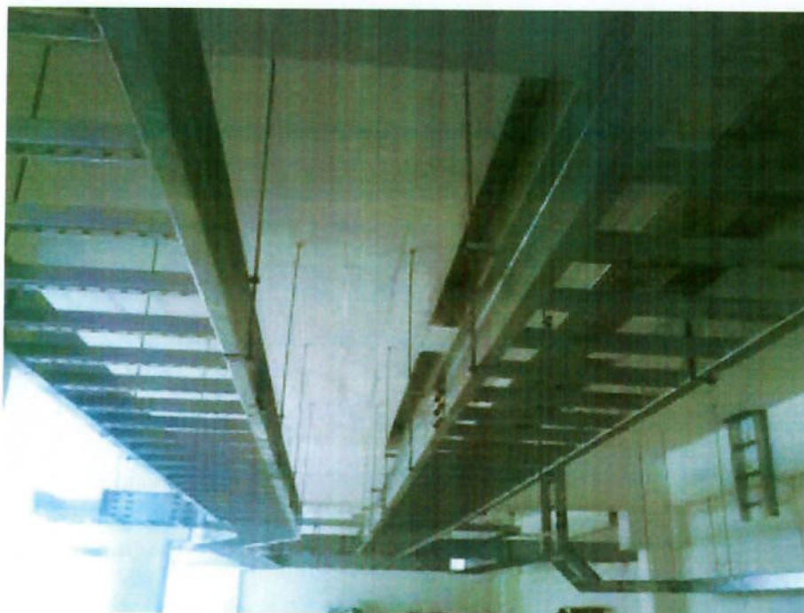
Bandejamento de interligação dos painéis e equipamentos BCA's
