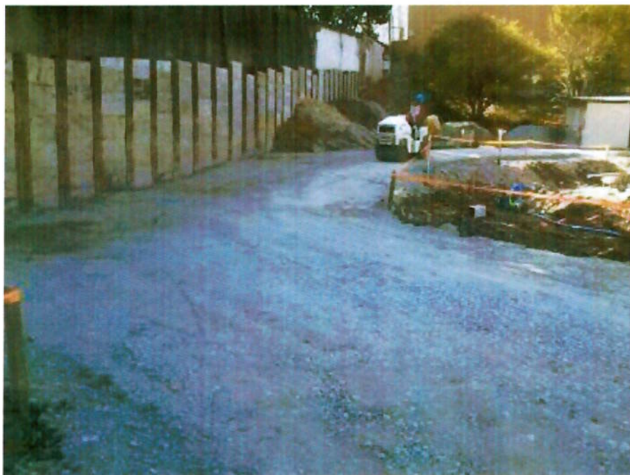
Compactação da bica-corrida para reforço de solo
