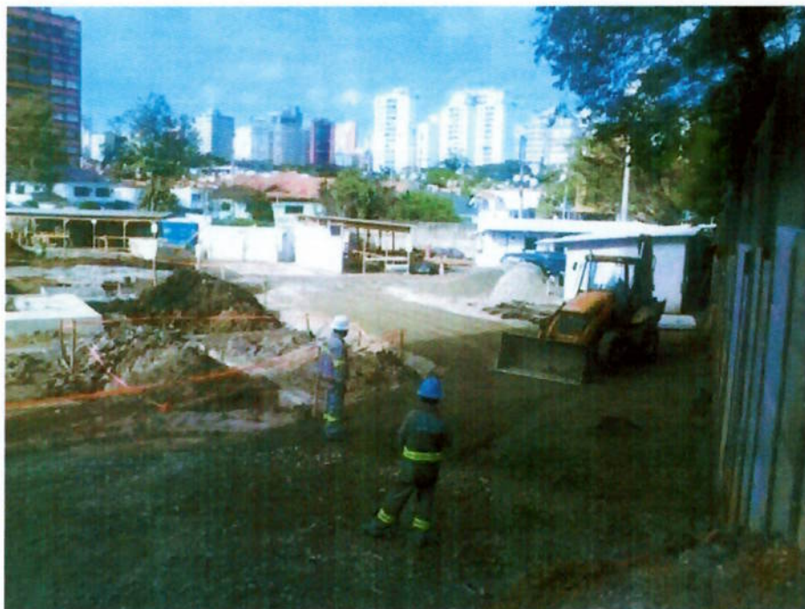
Espalhamento de bica corrida para reforço de solo
