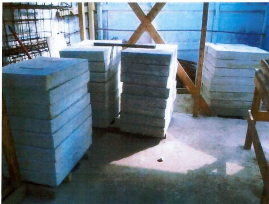
Tampas executadas aproveitando sobras de concreto
