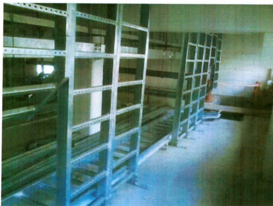
Bandejamento dos cabos de força dos Transformadores
