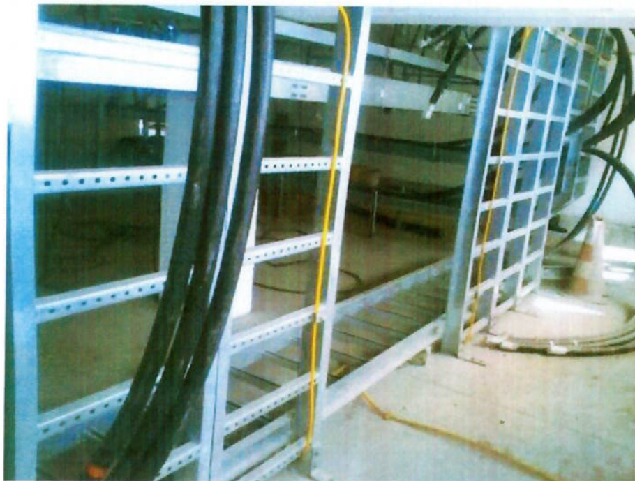
Aterramento dos bandejamentos
