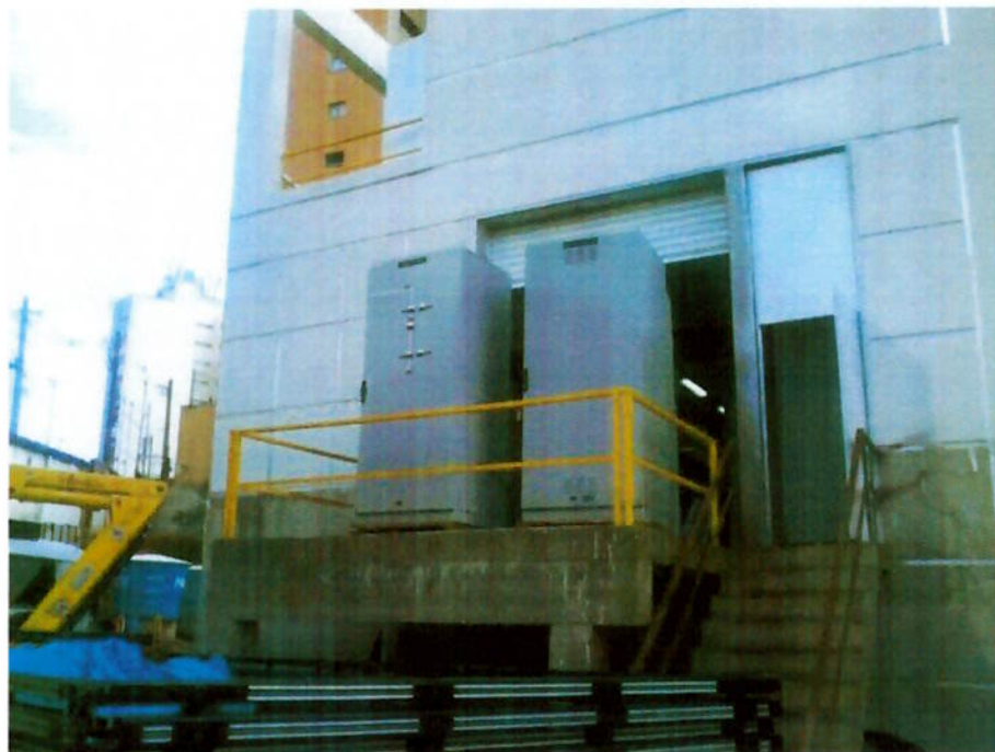
Descarga dos painéis em sequência adequada para o posicionamento final
