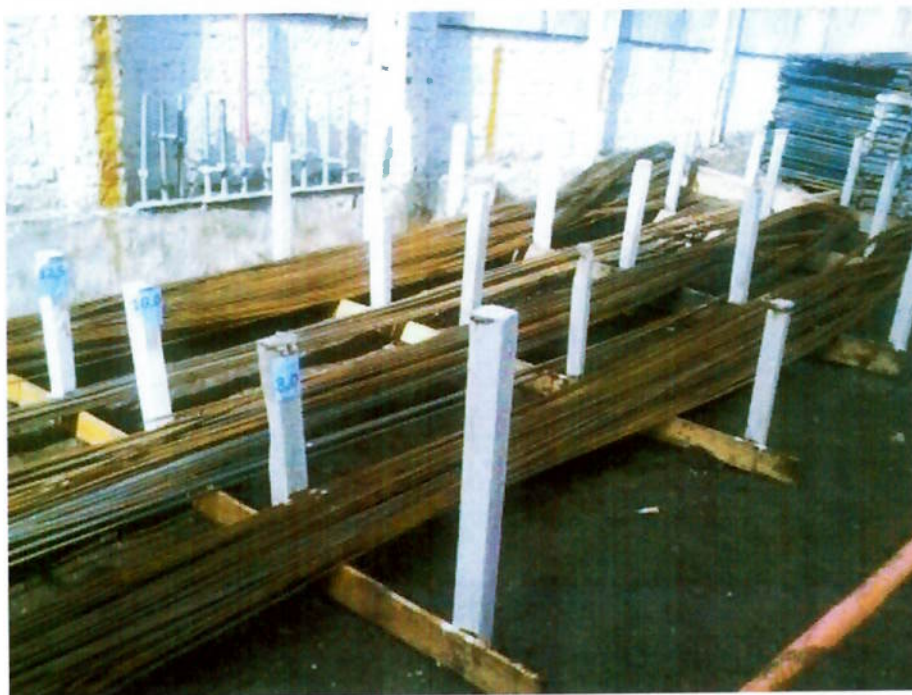
Figura 344 - Estoque de armação
