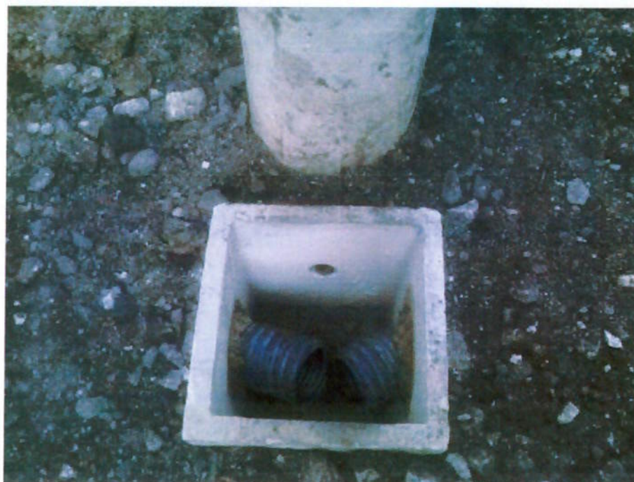
Infraestrutura para iluminação externa
