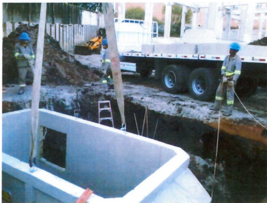
Deposição no posicionamento final
