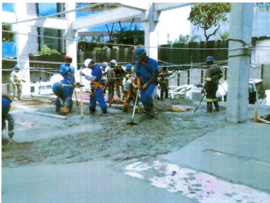
Conferência de nível durante o lançamento do concreto
