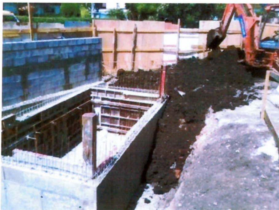
Caixa de retenção de águas pluviais
