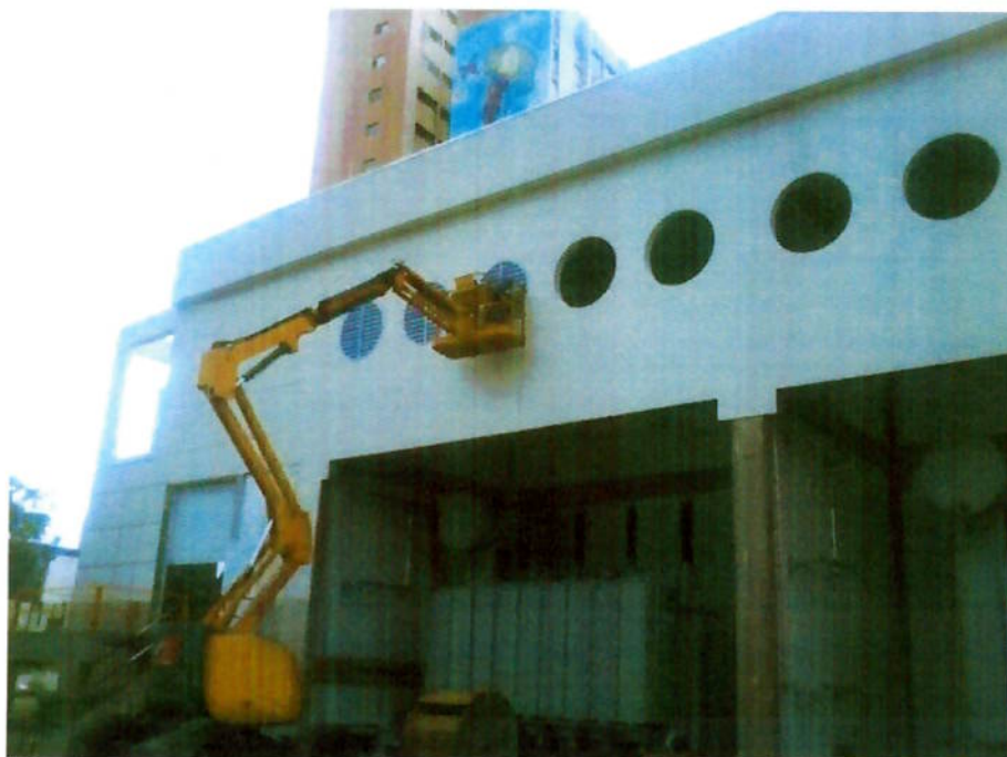
Instalação das esquadrias circulares de PVC
