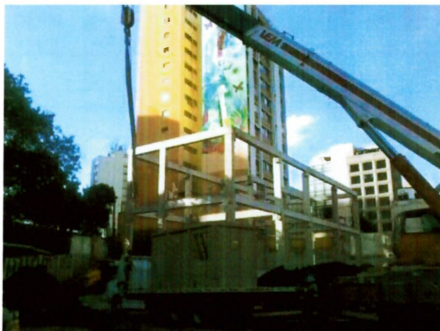
Recebimento e descarga do PI pré-moldado
