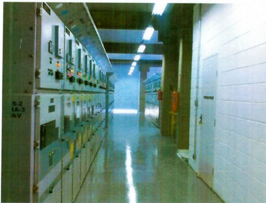
Revestimento auto-nivelante nível painéis e blindados
