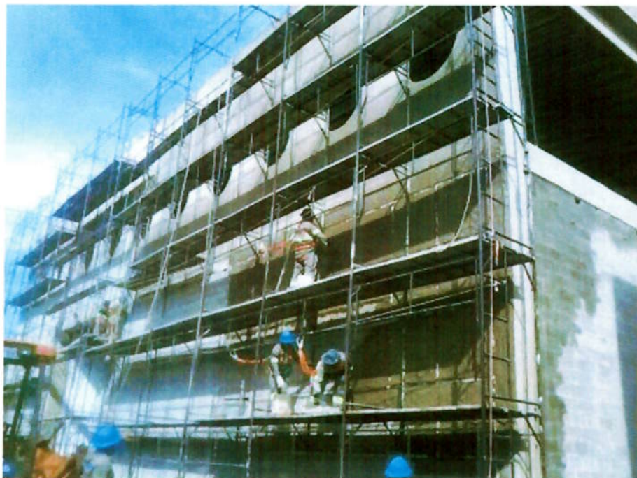
Revestimentos externos – chapisco e reboco (massa única)
