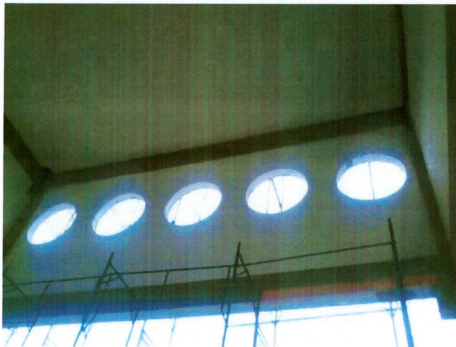
Pintura interna do Edifício dos Transformadores após o revestimento com argamassa com vermiculita
