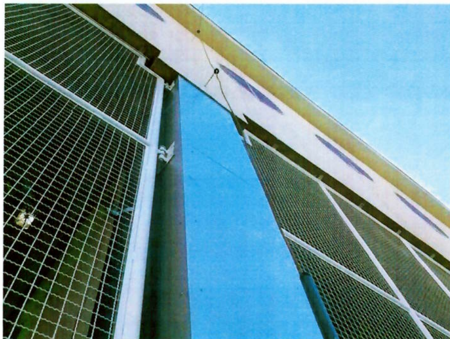
Revestimento dos pilares com alumínio
