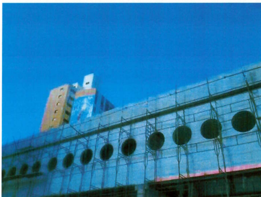
Vãos deixados para posterior instalação de esquadrias
