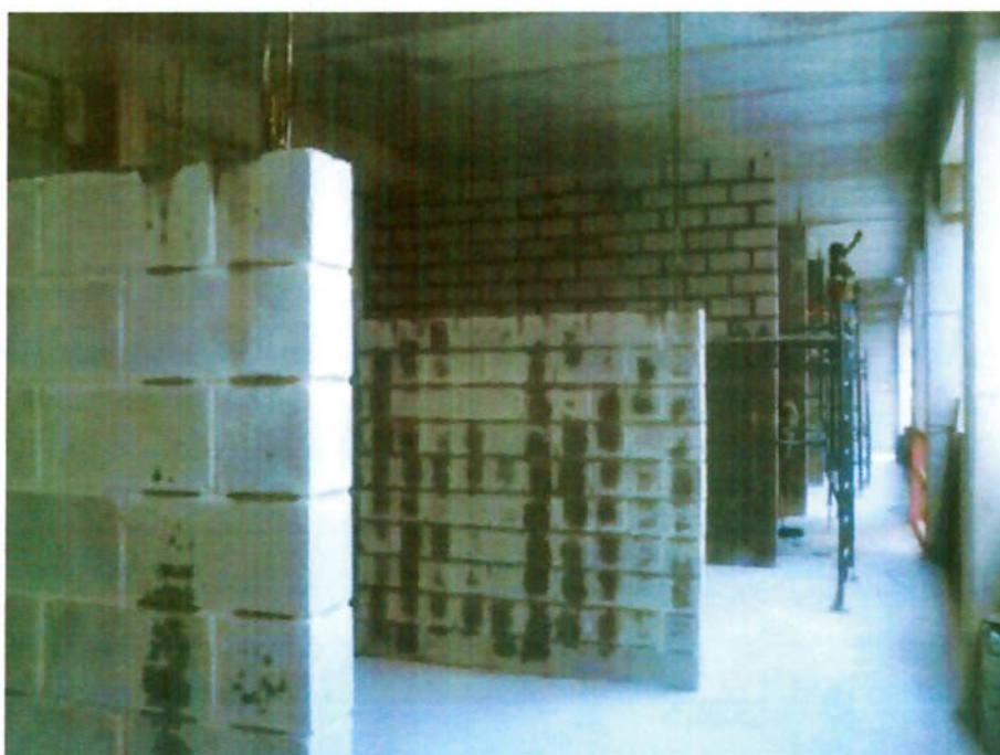
Alvenarias internas reforçadas para instalação futura dos BCA's
