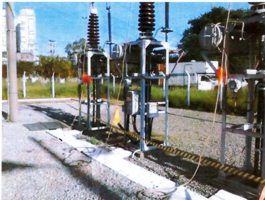
Aterramento da subestação alimentadora para manobras
