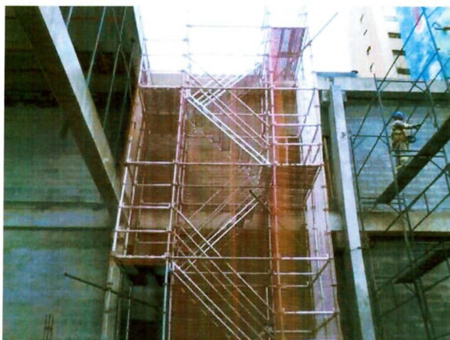
Andaime multifuncional para transporte interno de materiais
