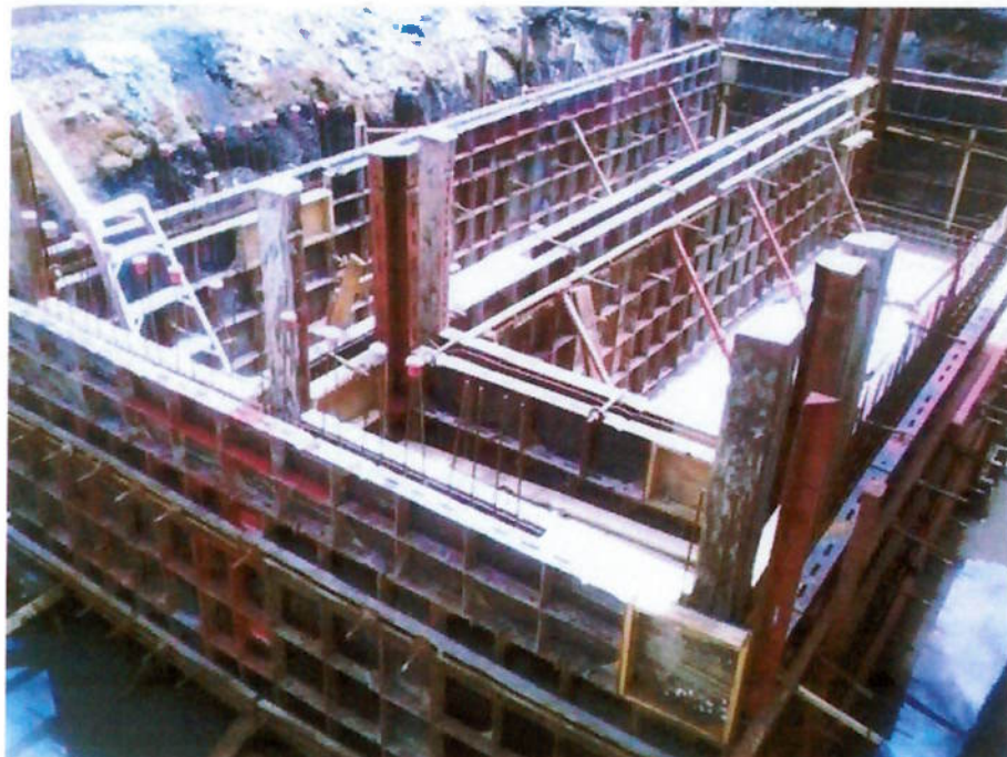
Caixa Separadora de Água e Óleo
