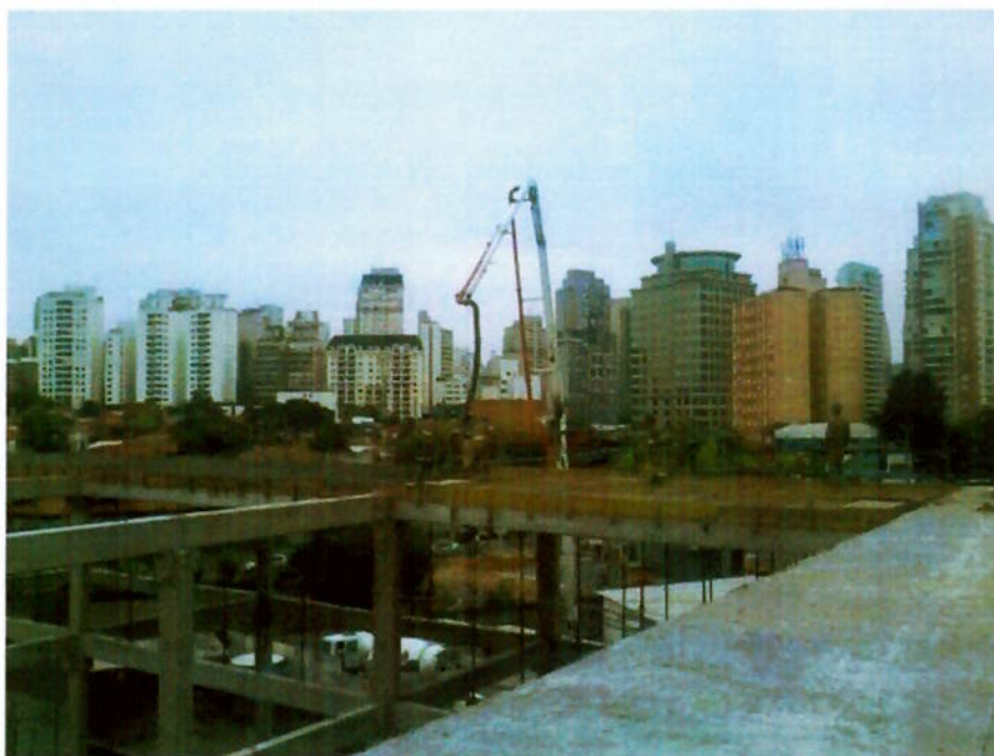
Concretagem de capa de laje alveolar com bomba tipo lança
