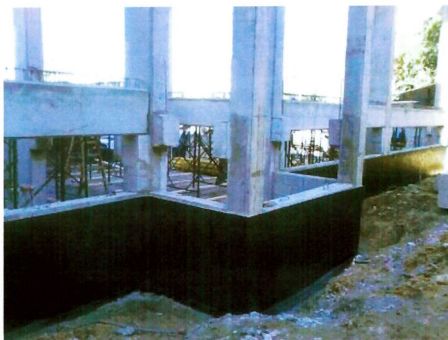
Alvenaria reforçada e impermeabilizada do porão de cabos
