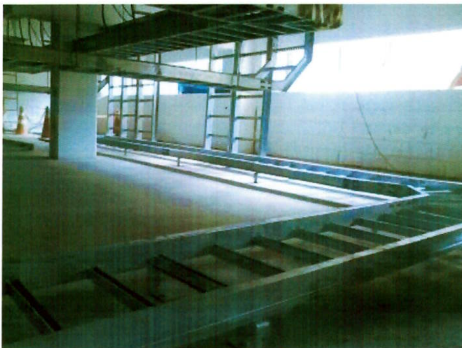
Bandejamento dos cabos de distribuição
